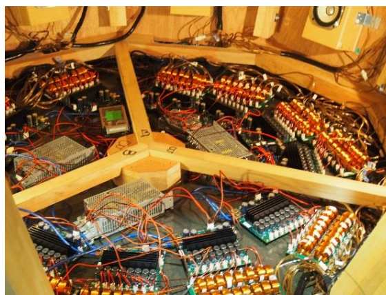
図 4 床下に設置した主要な機材
